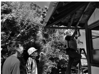
2022年に取り組んだ古民家改修の様子
